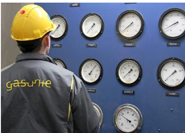
Zodra de rode stip op de helm helemaal wit is, moet de helm vervangen worden.
